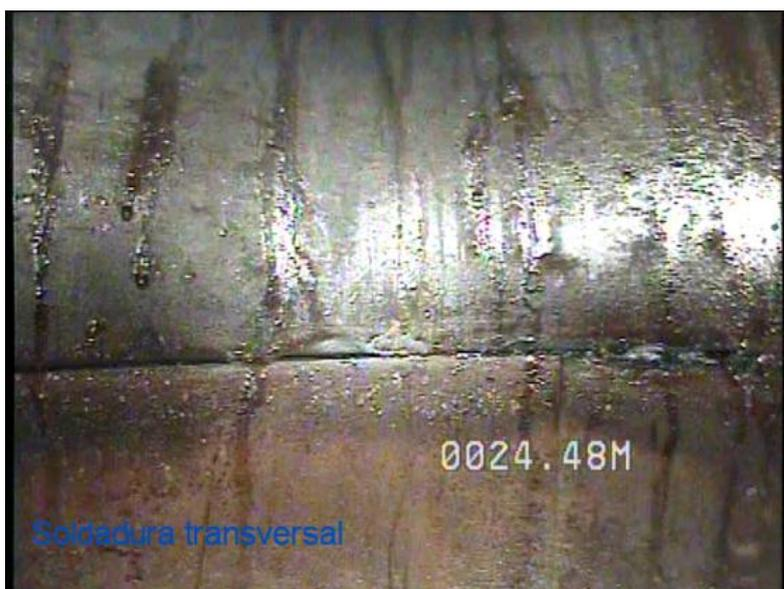
Soldadura transversal en buen estado, 24,48 m
