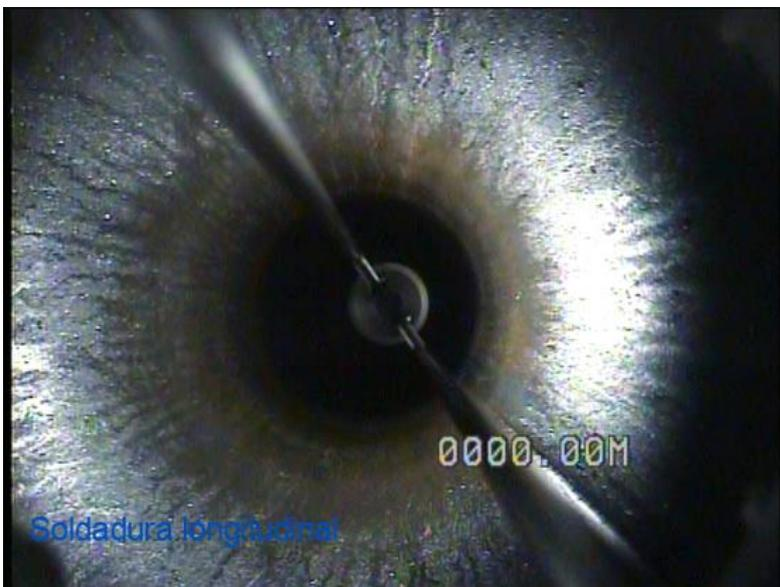
Tubería de soldadura longitudinal con orejetas cerradas, 0 m
